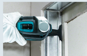
Wycinanie otworów drzwiowych
