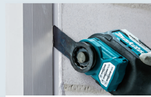
Wycinanie uszczelnień, silikonu, kitu
