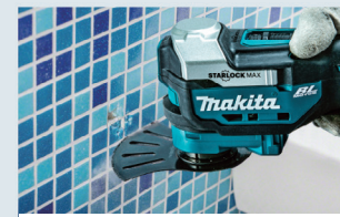
Wycinanie fug na płytkach ściennych
