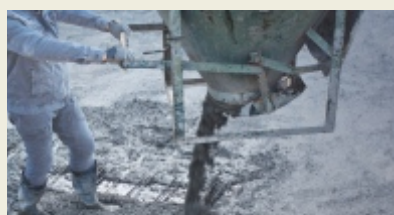
Wylanie świeżego betonu
