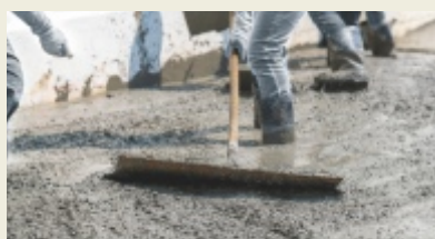
Rozprowadzanie mieszanki
