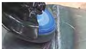
*Usuwanie niebieskich przebarwień spoin
